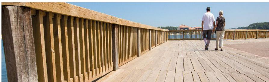
platelage et garde corps en pin maritime - port d'Albret
