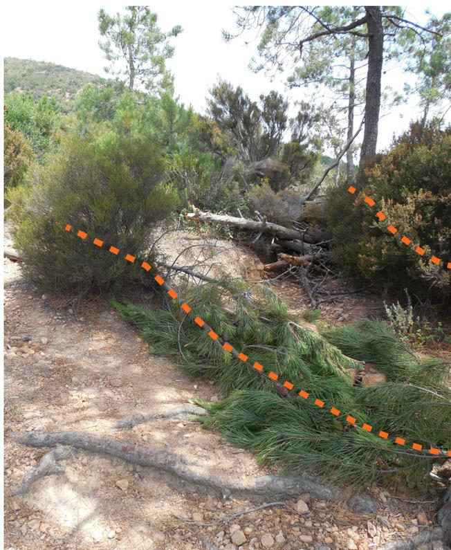
Effacement de sentier par la mise en place de matériaux du site (branchages de pin) sur une longueur de 10m
