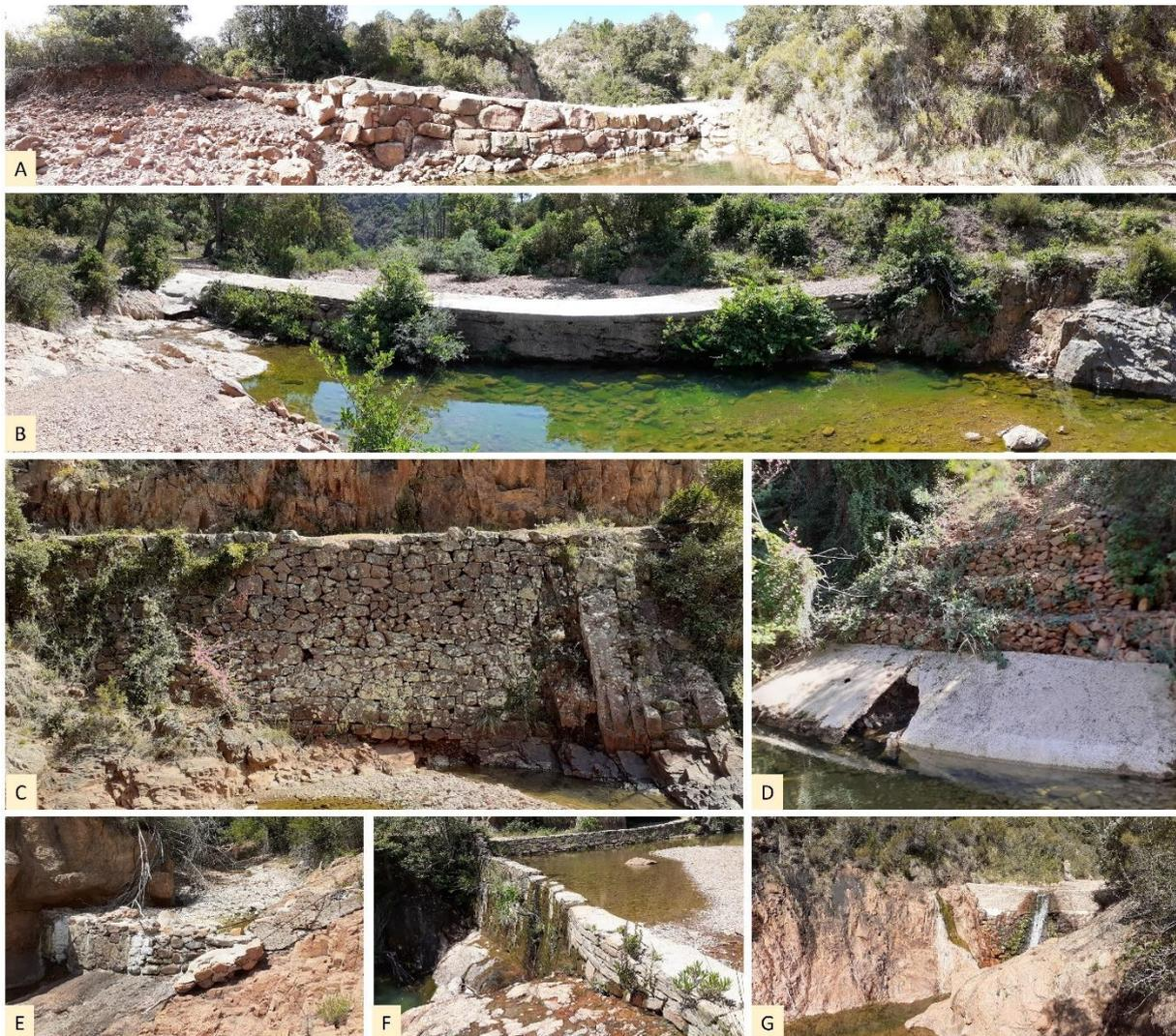
**Figure 35. Vues sur quelques aménagements anciens et récents. A - Passage à gué inférieur de la piste du Mal Infernet ; B - Passage à gué supérieur de la piste du Mal Infernet ; C - Mur de soutènement en pierre sèche ; D - Disposition récente de soutènement par gabion et béton ; E - Seuil du ravin des Trois Thermes ; F et G - Seuils amont et aval du ravin du Mal Infernet (Photos sur site - Naturalia)**
