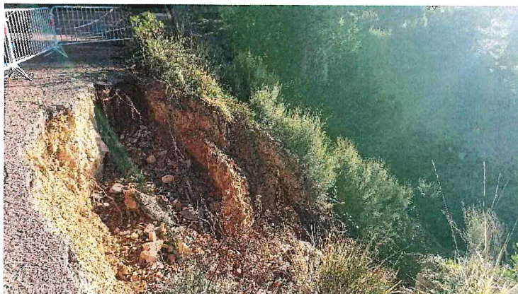
Figure 1 : éboulement piste DFCI H34 Plateau Anthéor - Route fermée
