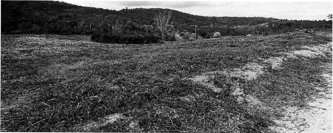
Figure 3 : piste DFCI F17 Charrette - Commune de Roquebrune-sur-Argens
