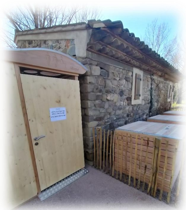
Toilettes sèches - Commune de Roquebrune-sur-Argens
