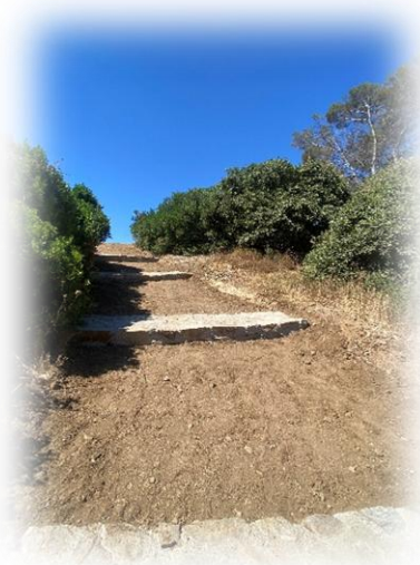
Travaux sentier du littoral des Issambres - Commune de Roquebrune-sur-Argens
