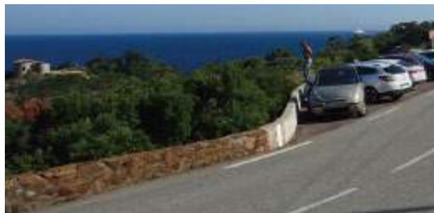
Muret béton accolé au muret de pierre rhyolitique © Agence aps
