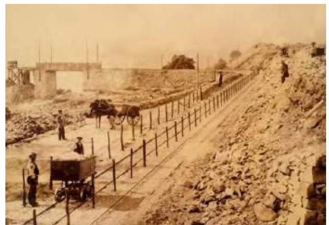
1895 – Les carrières de Porphyre, collection Médiathèque St Raphaël / fonds Carlini – photo J. David (© blog du Collectif des Copropriétaires de Cap Estérel)
