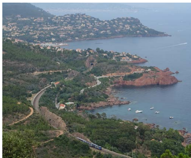
La Corniche d'Or, voie ferrée et le Trayas
