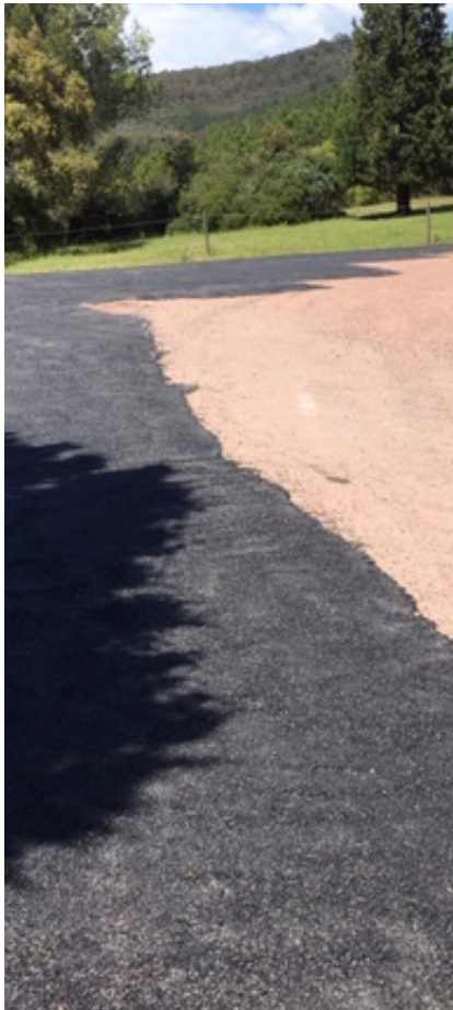
Roussiveau - Réparation de chaussée
