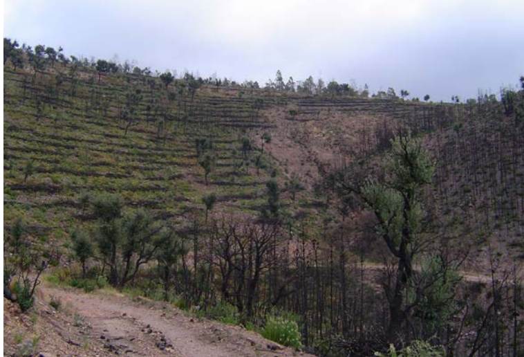
Fascines aidant au maintien du sol pendant le développement de pelouse, cistaie et maquis bas
