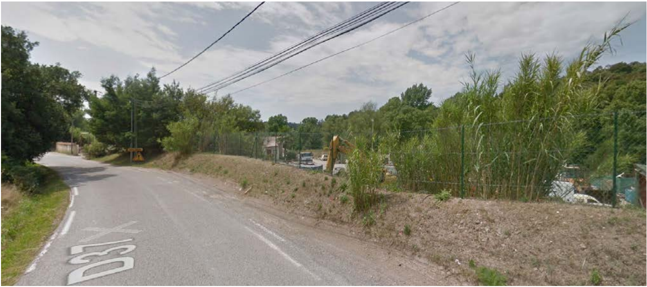
D37 - Dépôt vallée du Reyran
