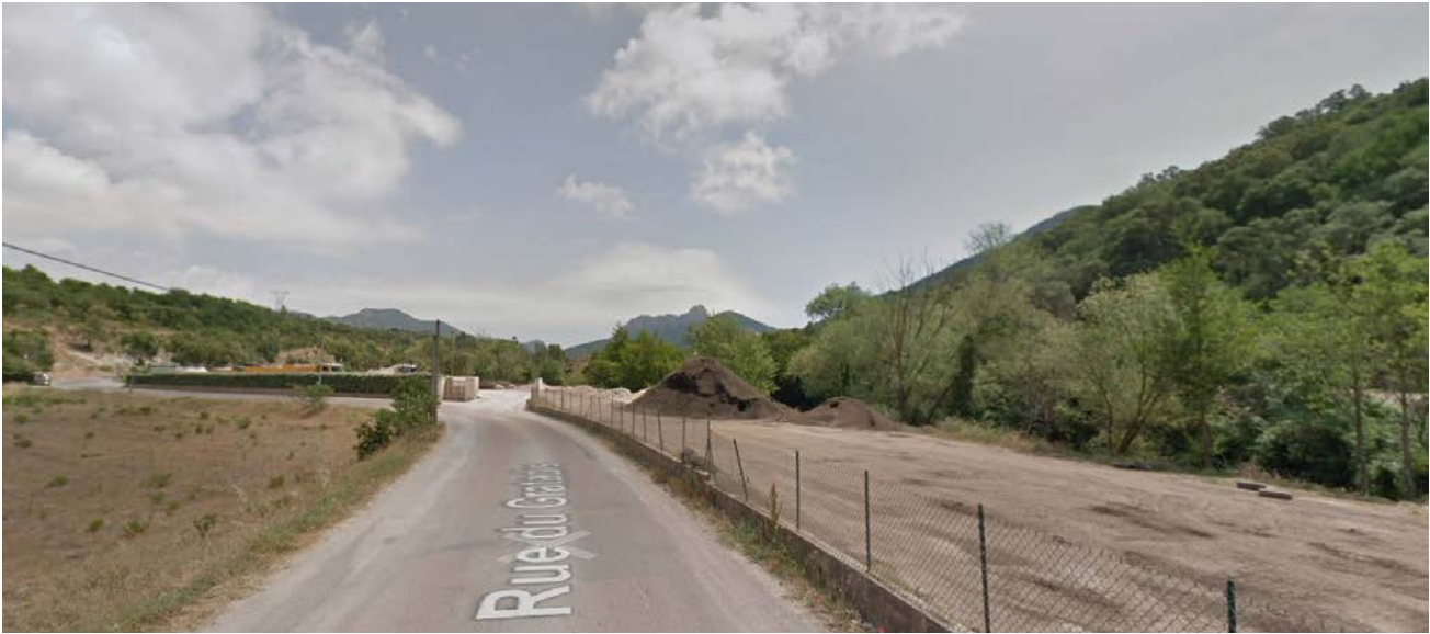
Route de Gratadis - Dépôt
