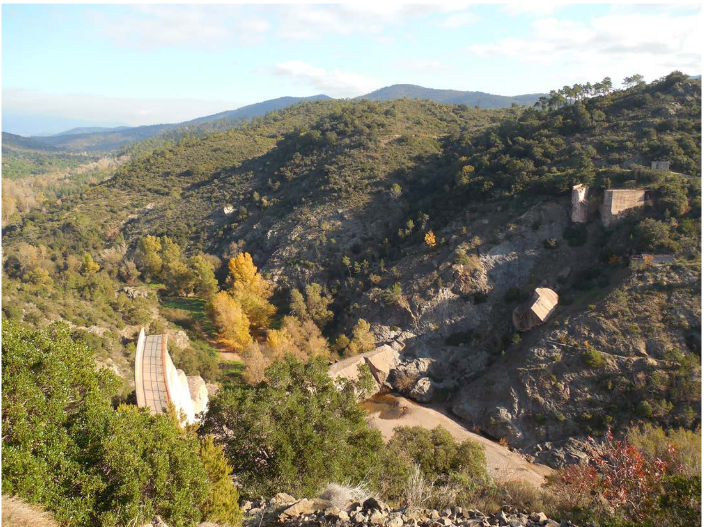
Ancien barrage de Malpasset
