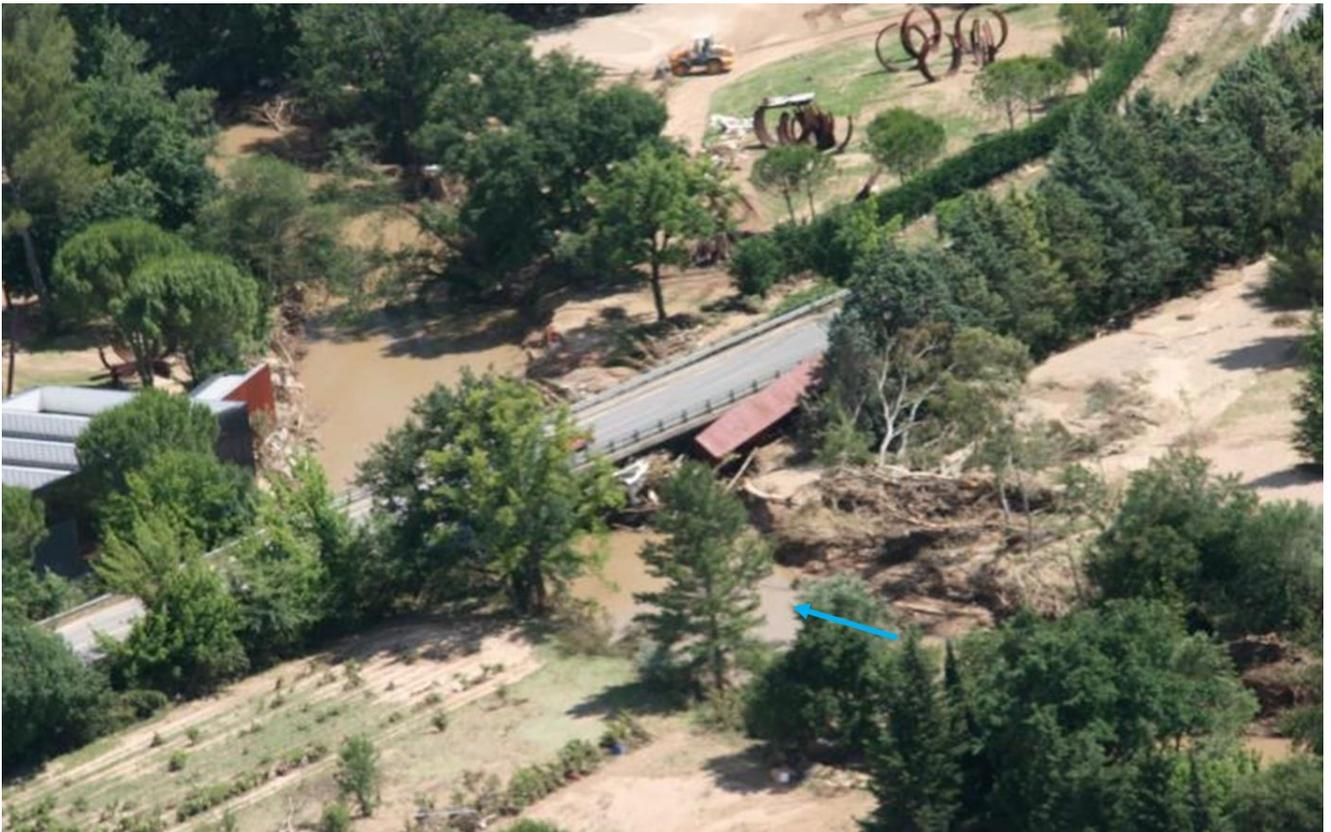
*Figure 349 : Formation d'un embâcle et accumulation de déchets sur le pont de la D25 au Muy
