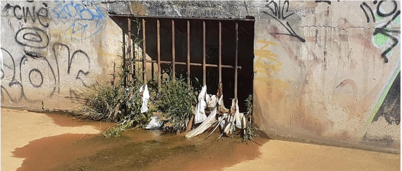
Figure 27 : Dégrilleur sur un exutoire dans le Pédégal
