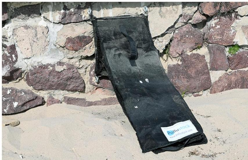
Figure 28 : Filet de piégeage des macrodéchets mis en place sur un émissaire à Mandelieu-la-Napoule
