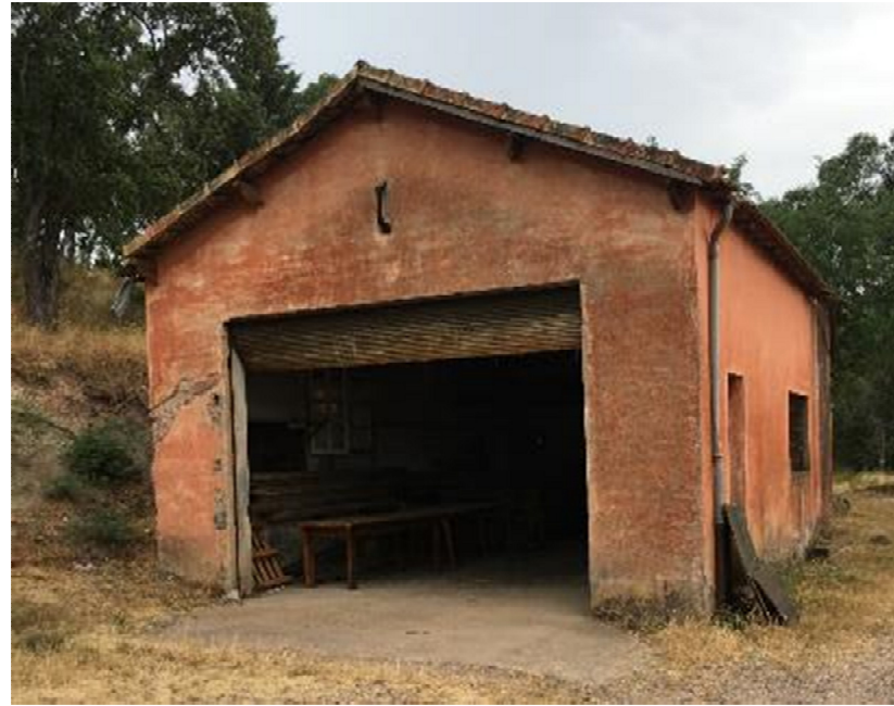
Vue d'ensemble du hangar
