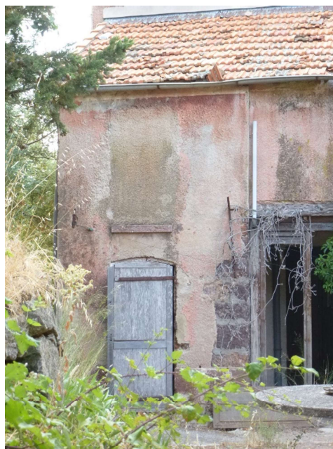
Détail façade sud
