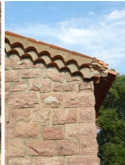
Détail d'un angle du toit
