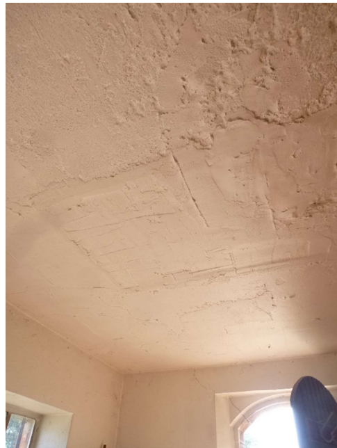
Détail du plafond (dalle)
