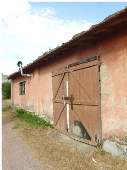
Vue de la façade nord
