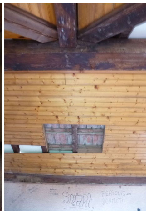
Détail des lambris bois en sous-toiture
