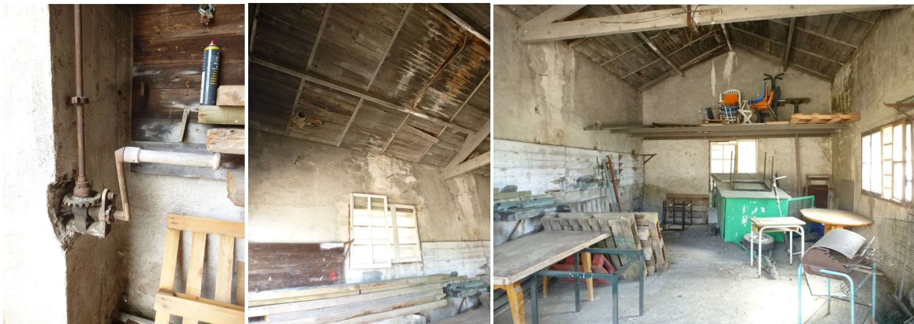
Détail de la manivelle actionnant le rideau en fer de la porte / Détail intérieur (voliges sous-toiture) / Vue générale intérieure depuis l'entrée vers l'ouest
