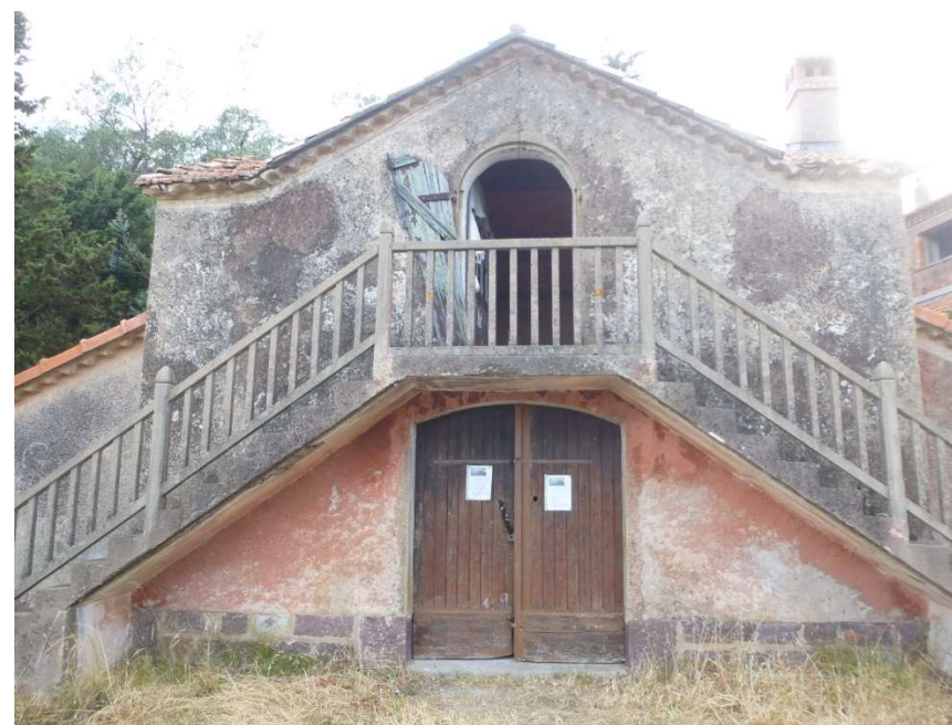
Vue de la façade est, depuis la voie
