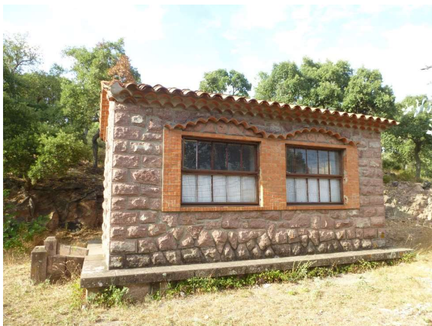
Vue de la façade sud-ouest, depuis l'esplanade
