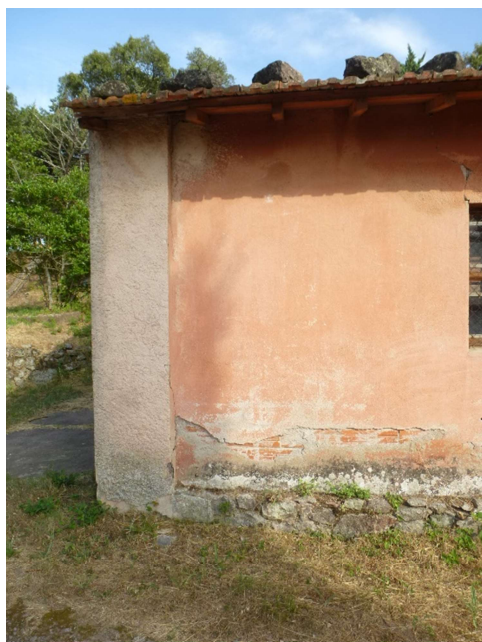
Détail de l'angle nord-est, depuis la voie
