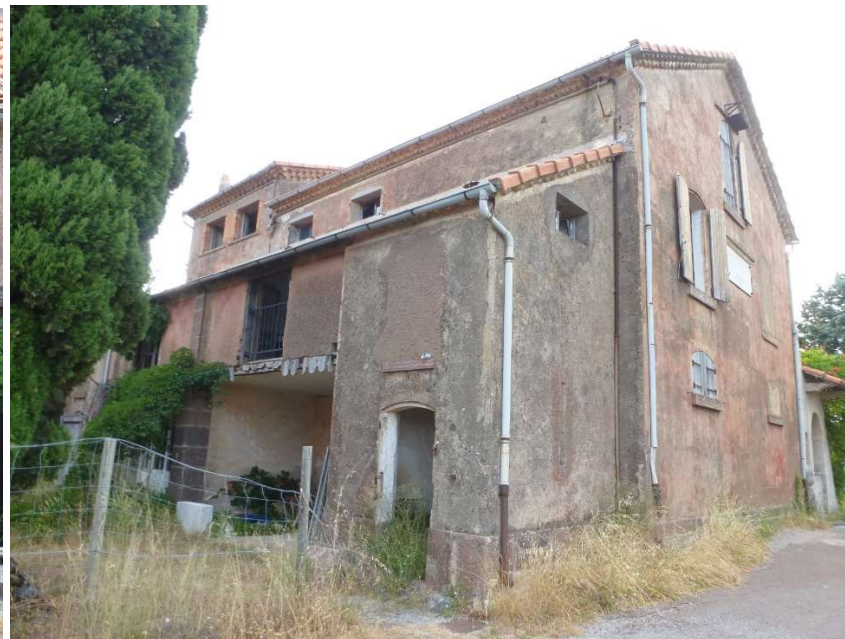
Vue de l'angle sud-est, depuis la voie
