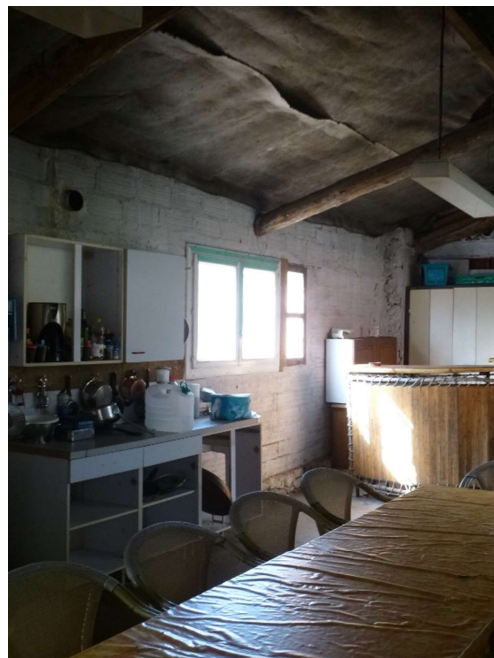
Vue intérieure vers le nord
