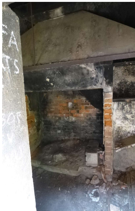
Vue de la cheminée sous abri
