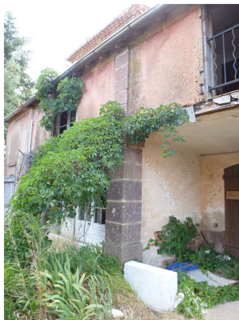
Détail façade sud sur cour
