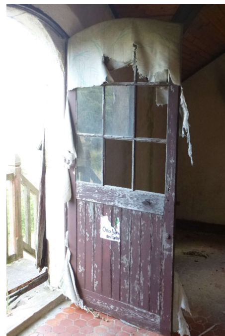
Détail de la porte de l'étage
