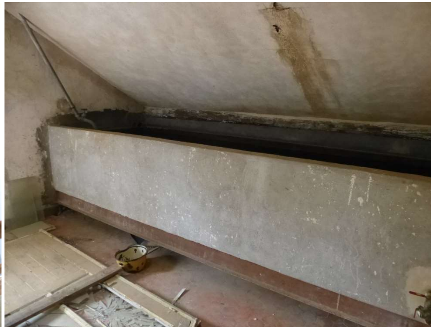
Détail de l'un des bassins de récupération en comble
