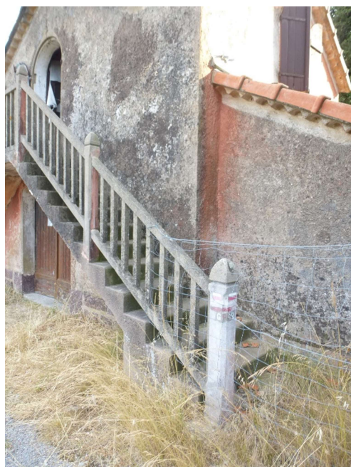
Détail de l'escalier extérieur, façade est
