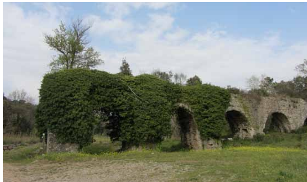
▲ 33 : vue depuis la H86 sur un vestige de l'aqueduc gallo-romain
