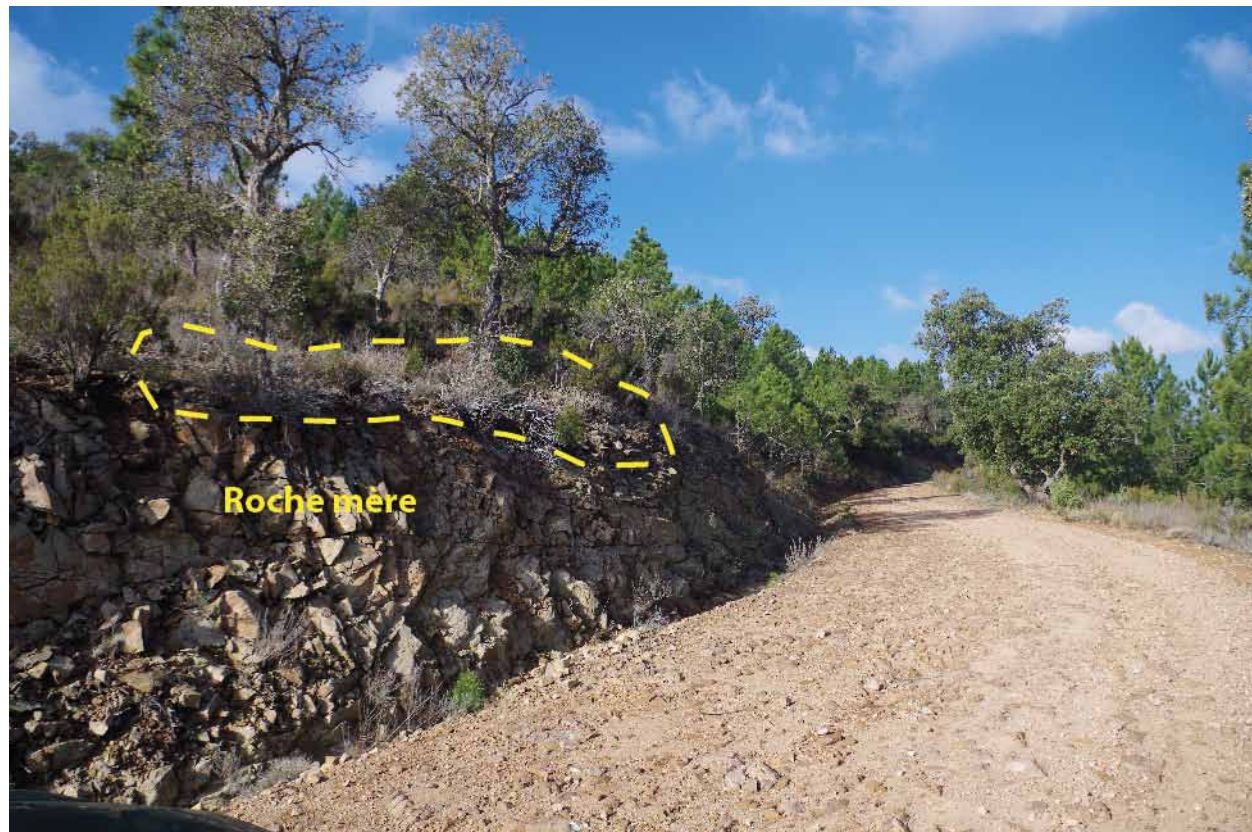
▲ 43 : Exemple de talus non revégétalisé (affleurement de la roche mère) - maintien de mottes en tête de talus (H17)
