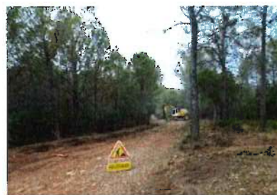
Signalisation du chantier
