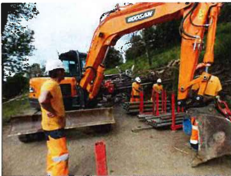
Piste H86 de l'Armélie : forage pour la mise en place des purges et mise en place
