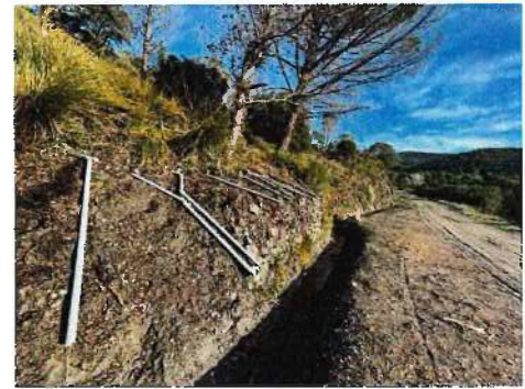
Piste H86 de l'Armélie : forage pour la mise en place des purges et mise en place
