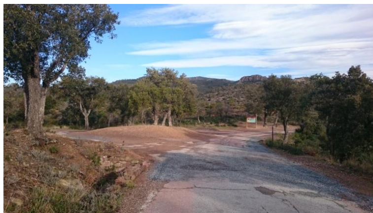
Carrefour de Colle Douce réhabilité
