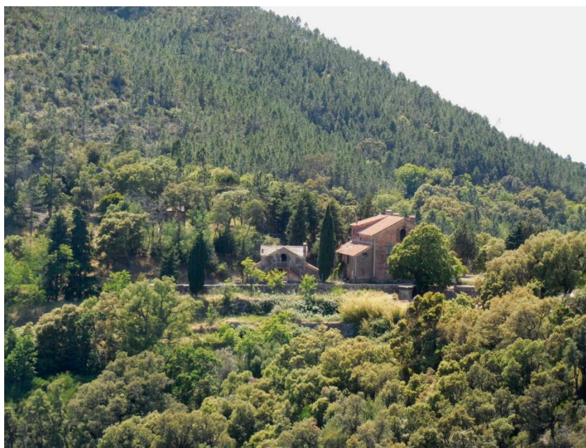
Vue sur la Maison Forestière du Malpey
