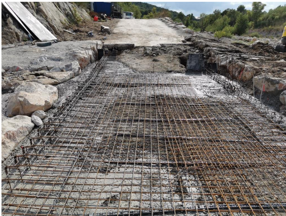
Pendant les travaux
