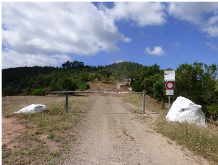
Bulldozer sur la piste H 75 de Cante Perdrix à Fréjus
