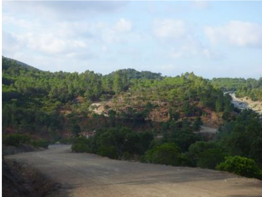
Piste DFCI H 86 de l'Armélie : résultats après passage des équipes du Pôle Génie Civil du Département du VAR
