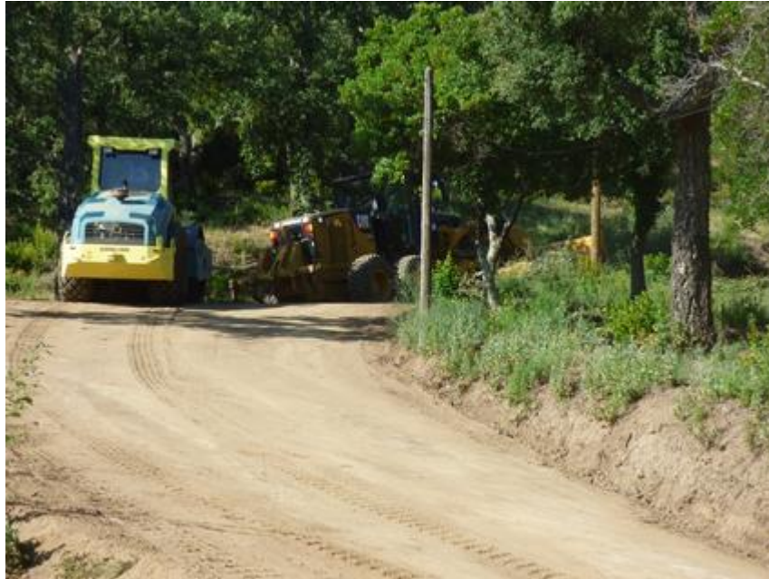
Niveleuse et compacteur sur la piste G 21 de Magail à Bagnoles-en-Forêt
