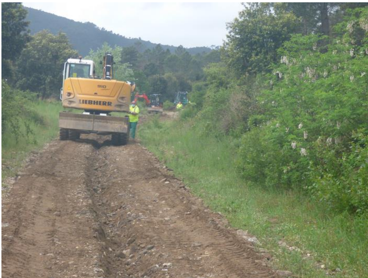
Rebouchage de la tranchée dans la piste DFCI G 31 de Malpasset
