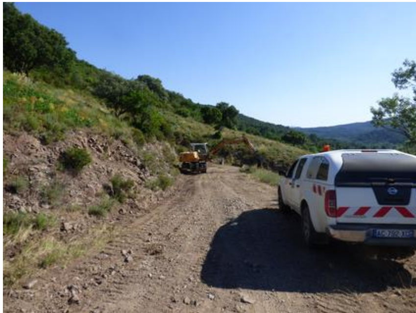
Curage des fossés à la pelleteuse à pneus sur la piste G 21 de Magail à Bagnoles-en-Forêt
