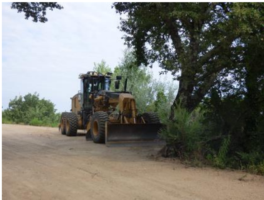
Niveleuse sur la piste G 52 des Escolles à Bagnoles-en-Forêt
