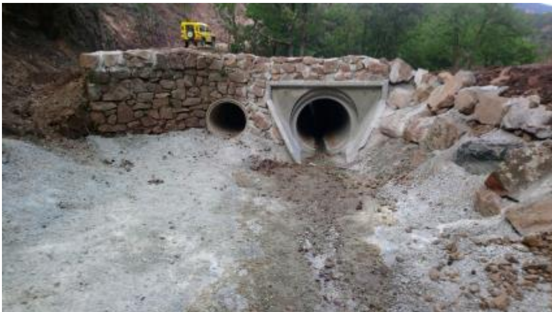
Piste DFCI H 23 des Charretiers : avaloir et buse après travaux
