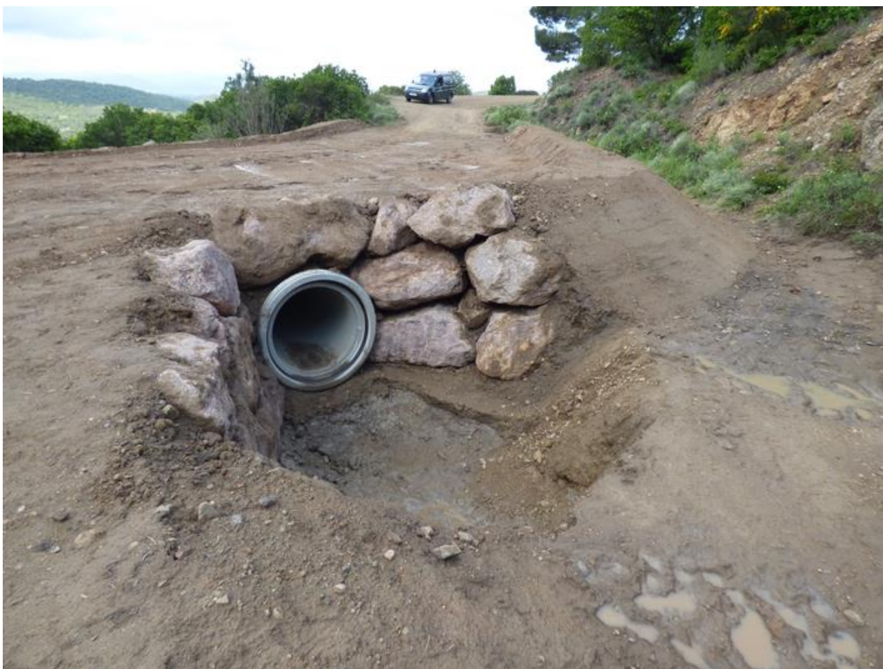
Création d'un passage busé sous la piste DFCI H 79 de l'Esquine à Fréjus
