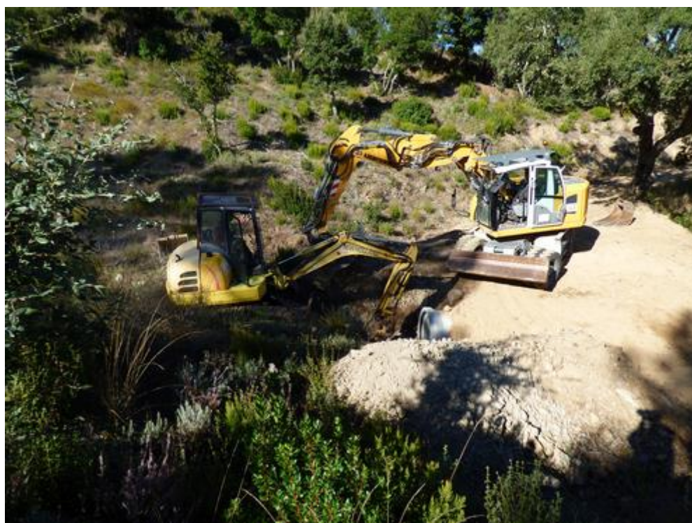
Réalisation d'un passage busé sur la piste G 52 des Escolles à Bagnols-en-Forêt
