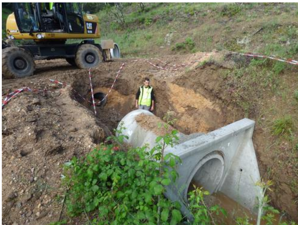
Création d'un passage busé sous la piste DFCI G 52 des Escolles à Bagnols-en-Forêt
