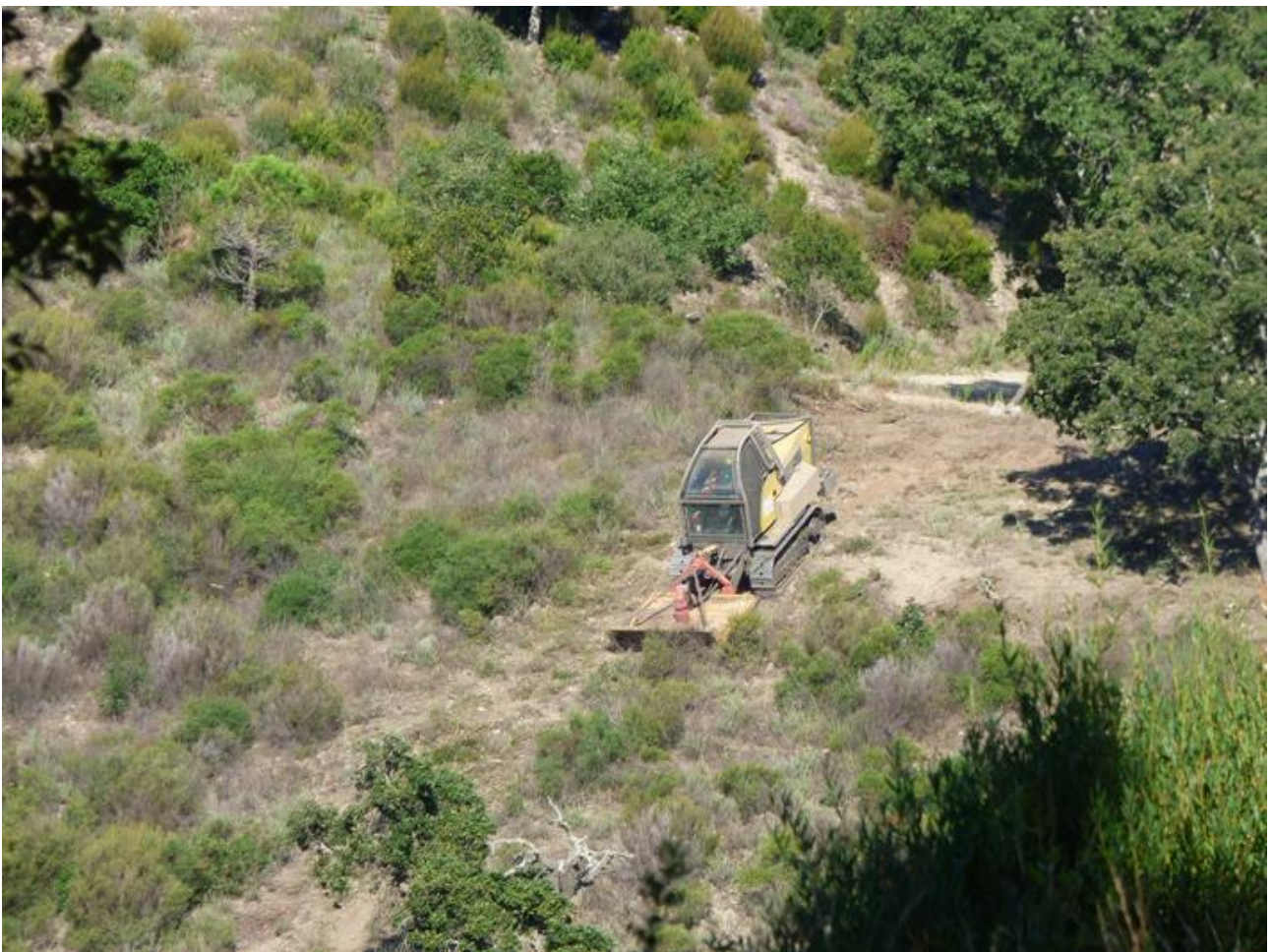
APFM : gyro-broyage de la végétation sur piste DFCI H 83 de Font Freye aux Adrets de l'Estérel
